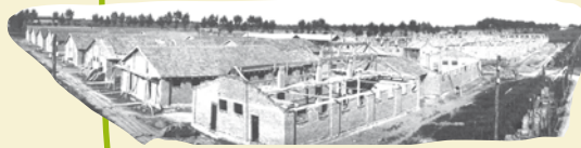
Campo di Concentramento di Fossoli
